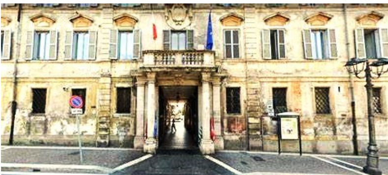
Sopra: la sede della ASL RM6 ad Albano Laziale
